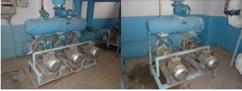
Resim 5.1. 7,5 kw ve 4 kw devirdaim motorları
