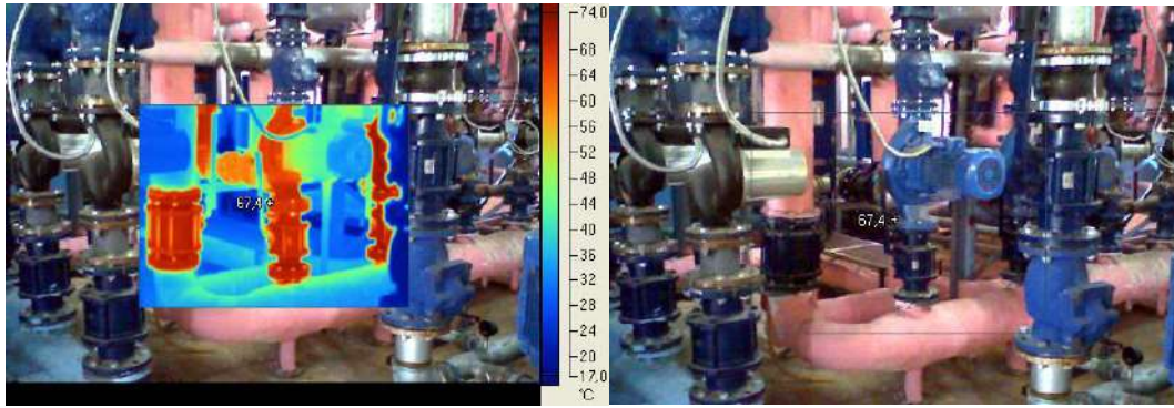
Resim 4.2. Kazan Gidiş ve Dönüş Vanaları
