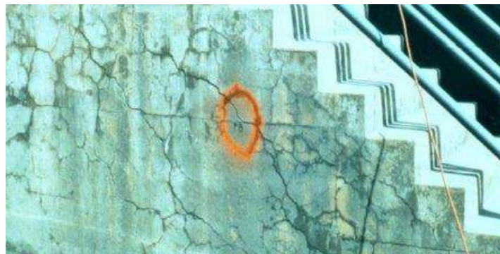
Рис.12: Растрескивание из-за щелочно-кремниевых реакций
