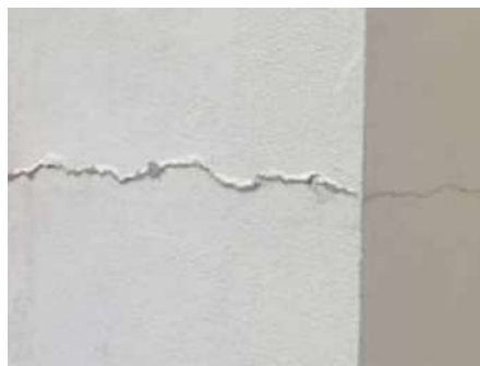
Рис.2: Растрескивание вследствие теплового движения
