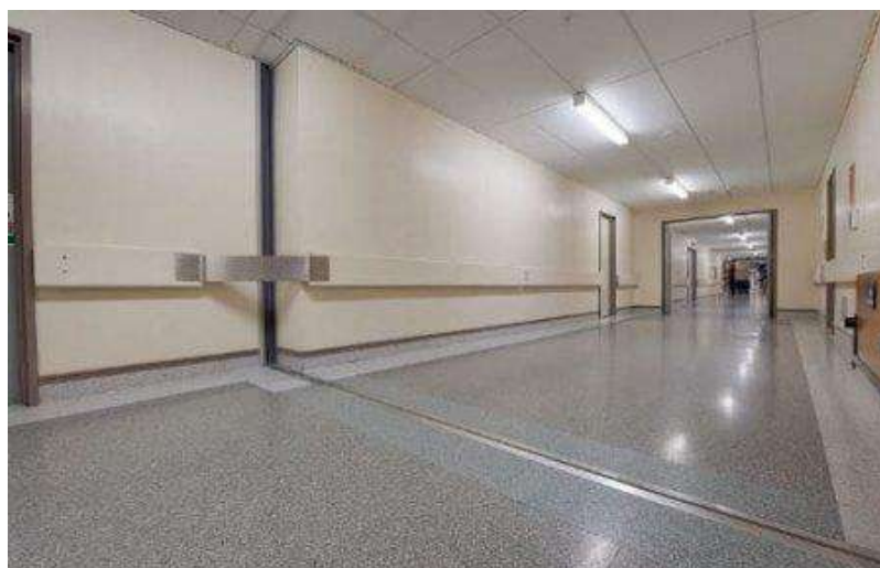
Рис.3: Соединения для предотвращения трещин вследствие теплового движения
