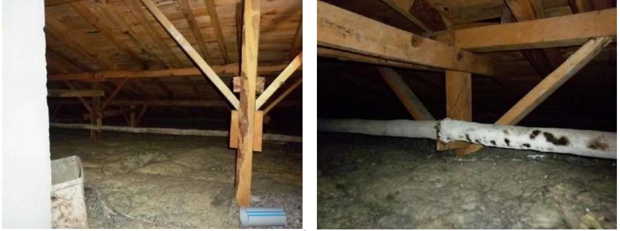
Resim 2.1. İdari Bina Çatı
